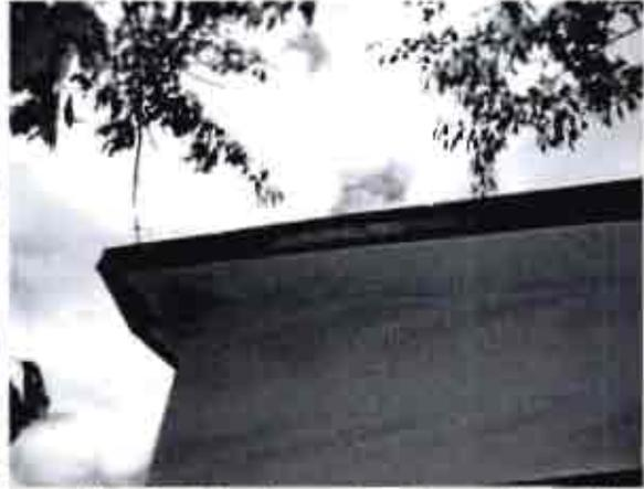
Junquillo instalado entre la unión del alero con el muro exterior no cumple escuadria.
